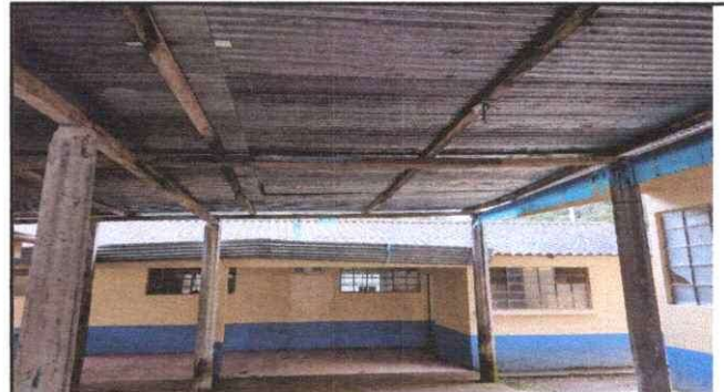
Foto 2: se observa claramente la estructura del mal estado, el salón de actividades, sustitución de vigas y costaneras de madera por metal
