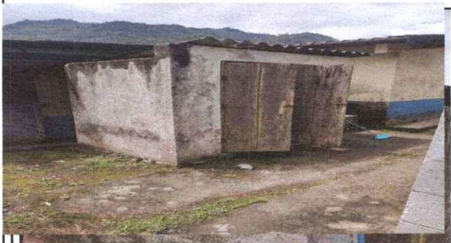
Foto 5: Se observa la necesidad de sustituir la estructura de madera por metal y las láminas de los baños
