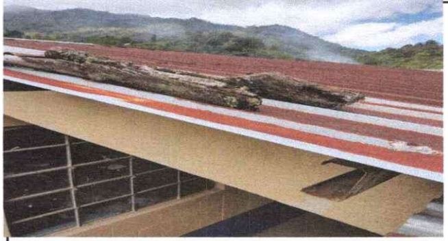
Foto 4: se mira la necesidad de cambiar las láminas por troqueladas modulo II
